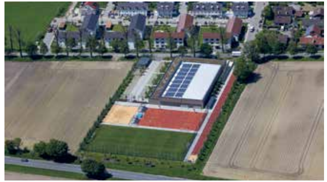
Schulsporthalle Gymnasium Ismaning; Photovoltaikanlage; Foto: Klaus Leidorf
