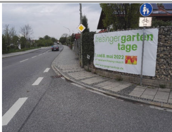
ungenügende Bordsteinabsenkung am Fasanweg
