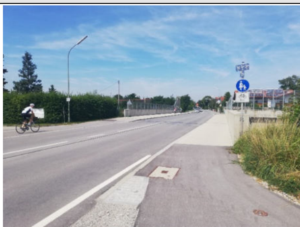
Rutschgefahr durch Kieseintrag südlich der Brücke
